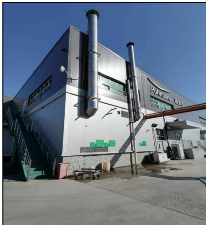
锅炉排气筒（2个）
