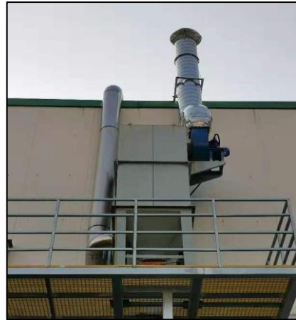
粉尘（布袋除尘）排气筒 01
