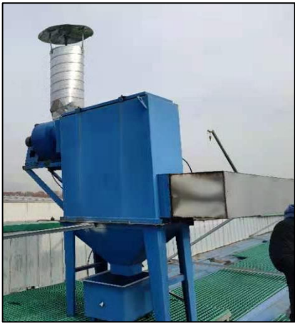
粉尘（布袋除尘）排气筒 02
